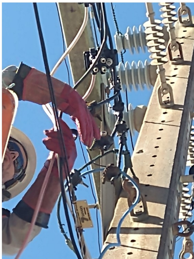
Figura 9 - Instalação dos conectores na rede.
