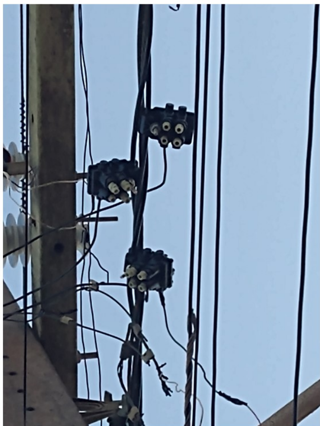
Figura 9 - Instalação dos conectores na rede.
