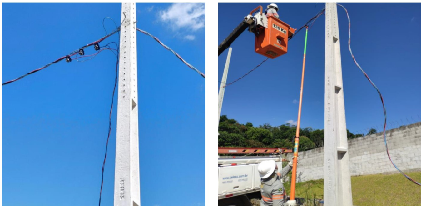
Figura 5 - Instalação CONEX 4S e manobra do solo.
